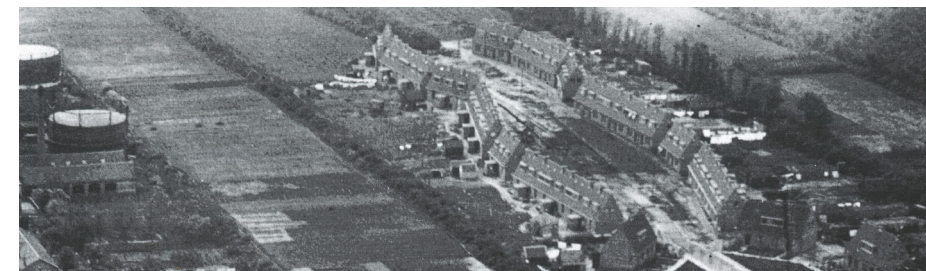
Aanleg Keucheniusstraat jaren 20
