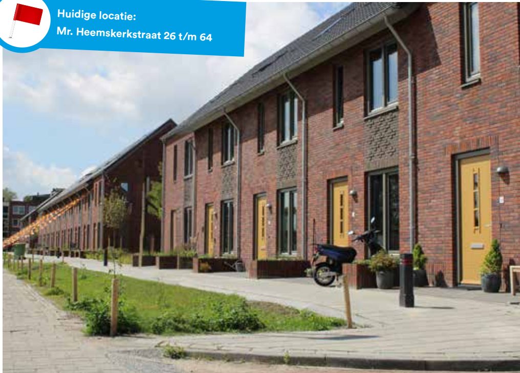
Nieuwbouwwoningen Mr. Heemskerkstraat
