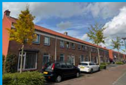
Huurwoningen W.C. Beeremansstraat, deelgebied 2B
