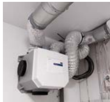
Voorbeeld van een mechanisch ventilatiesysteem
