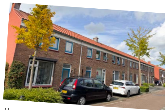
Huurwoningen W.C. Beeremansstraat
