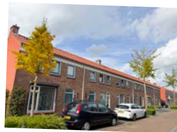
Huurwoningen W.C. Beeremansstraat
